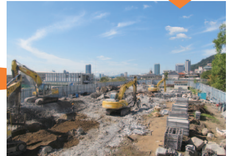
第2体育館の解体が終了
