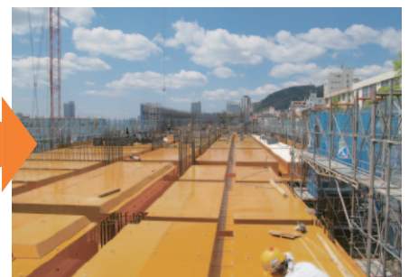
2013年4月22日現在の工事現場
