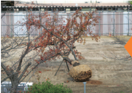
スタンド解体に向けて 植木の撤去が始まる
