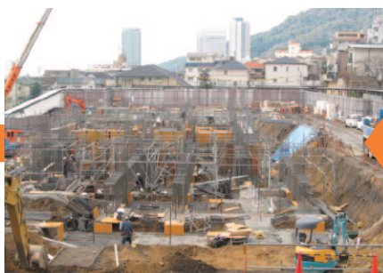
新校舎東側の基礎工事
