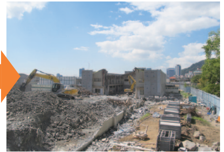
本館の解体工事が終わり 第2体育館の解体も始まる
