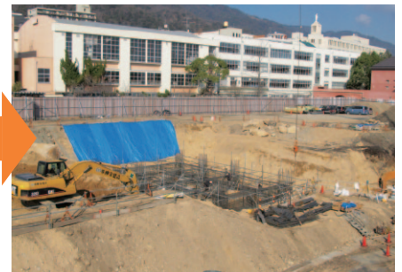
基礎工事のための鉄筋の 組み立て
