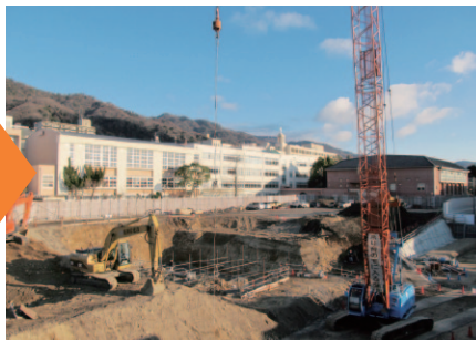
南館建設予定地の地下掘削
