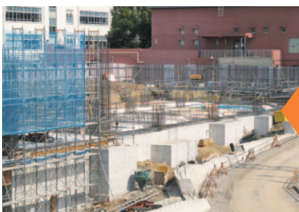
仮設校舎から見た 西側工事現場
