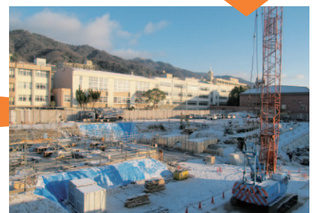
雪の朝の工事現場
