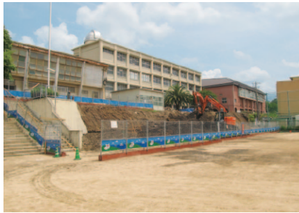
グラウンドへのスロープ建設工事
