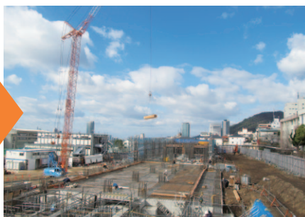
体育館側から見た工事現場
