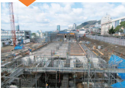
東側部分の1階フロアのための 枠組の状況
