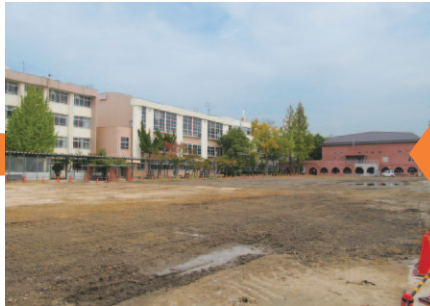
本館・第2体育館・部室解体後の跡地
