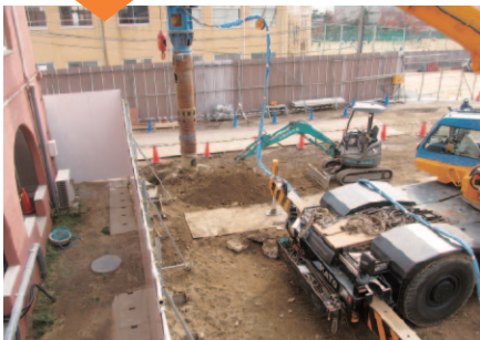
基礎工事が始まる
